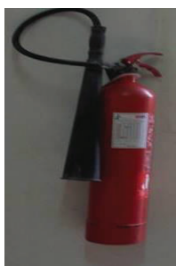
Extintor de CO 2
